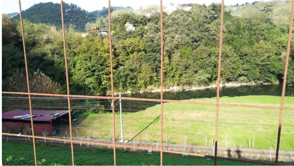
Caseta existente – Fuente: Debegesa
