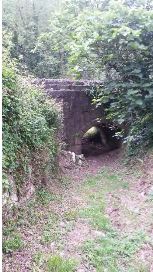
Paso bajo las vías del tren - Fuente: Debegesa
