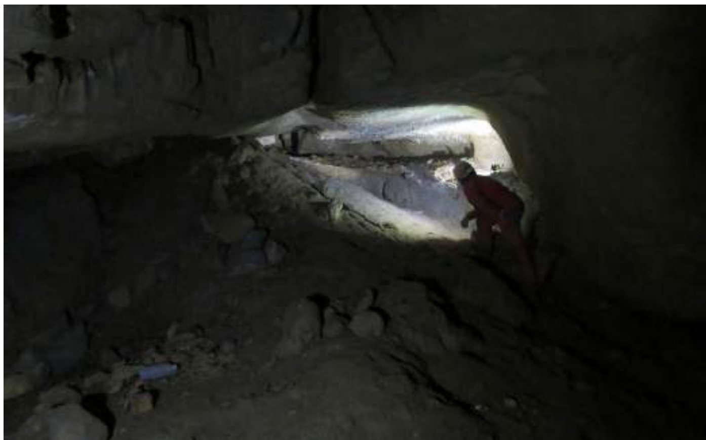
Foto de la galería post-derrumbe
