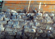
Desmuntatutako zenbaituki egin zituzten dobelak Dobelas numeradas para su desmontaje
