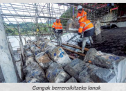
Gangak berreakuntzeko lanak Reconstrucción de las bóvedas
