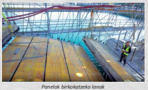
Panelak birlakatzeko lanak Reubicación de los paneles
