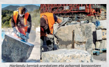
Harlandu berriak prestatzen eta zaharrik konpontzen Preparación de sillares nuevos y reparación de los antiguos
