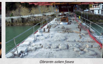
Obraren azken fasea Fase final de obra
