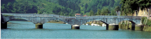
Zubia 2018ko uztailaren Seko goazildian bertan batean gertatutako kolapsuaren ondoren. Egurrezko pilotek ezin izan zioten eutsi pilaren pisuari. El puente tras el colapso súbito producido en el madrugada del 5 de julio de 2018. Los pilotes de madera no pudieron resistir el peso de la pila.
