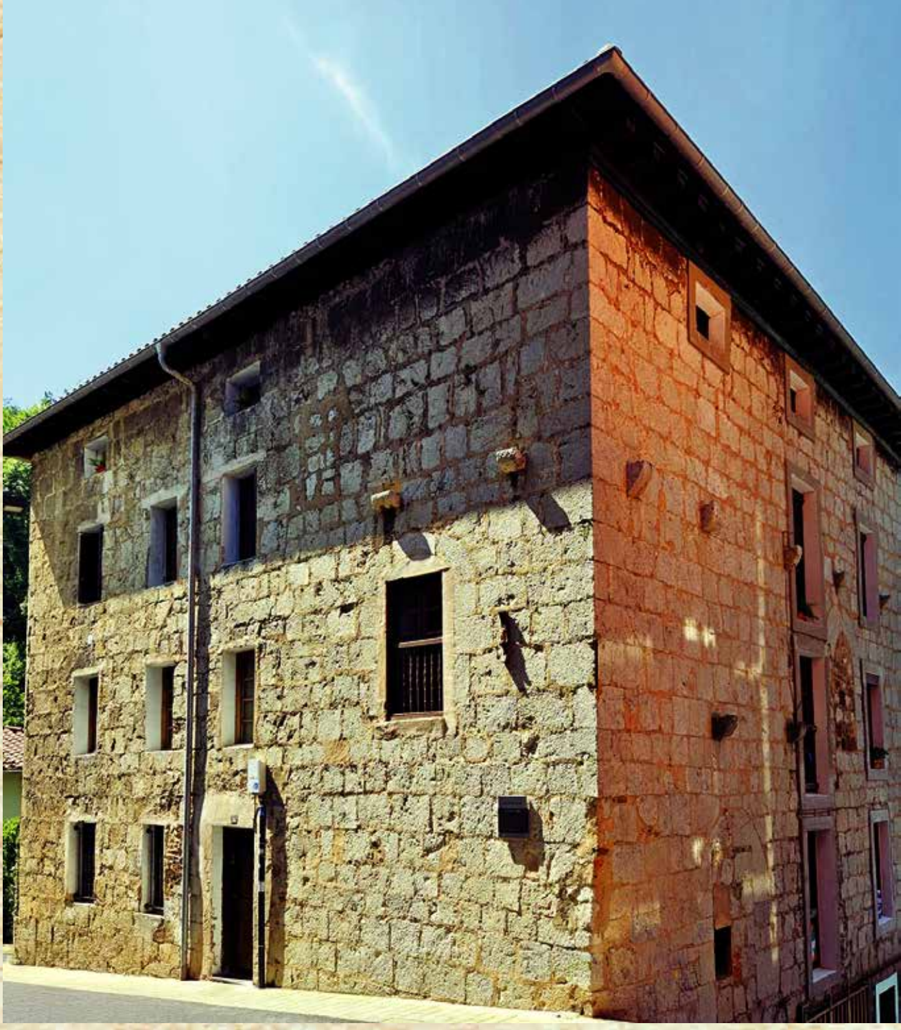
Eraikinaren ekialdeko fatxada. Bertan, hegal edo balkoiei eutsi zieten mentsulak eta leiñate itsutuak ikus daitezke. Fachada este del edificio, donde se aprecian las ménsulas que sustentaron los voladizos o balconadas, así como los ventanales cegados.
