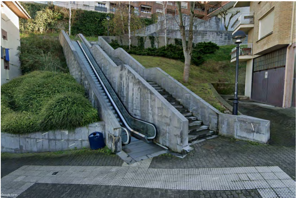
Eskailera mekanikoak eta, ondoan, beste eskailera: ukimenezko zoladureta gain, eskubandak ere falta dira.
