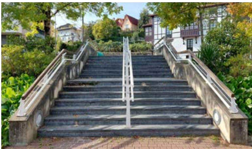
Eskubanda bikoitza eskaileraren erdian. Alboetako eskubanda, aldiz, bakarra da eta ez da ergonomikoa.
