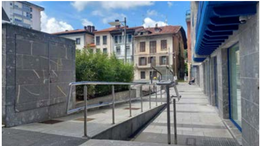
Eskubanda bikoitza alde bakarrean dago eta bere altuerak ez dira egokiak.
