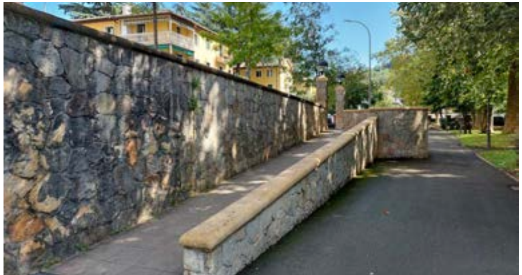
Arrapalek atseden hartzeko eskailera-buruak izan behar dituzte, eta zenbat eta malda handiagoa izan, orduan eta laburragoak izango dira hauen arteko tarteak. Asko dira tarte horizontalik gabeko arrapalak, Ordiziako hau, esaterako.
