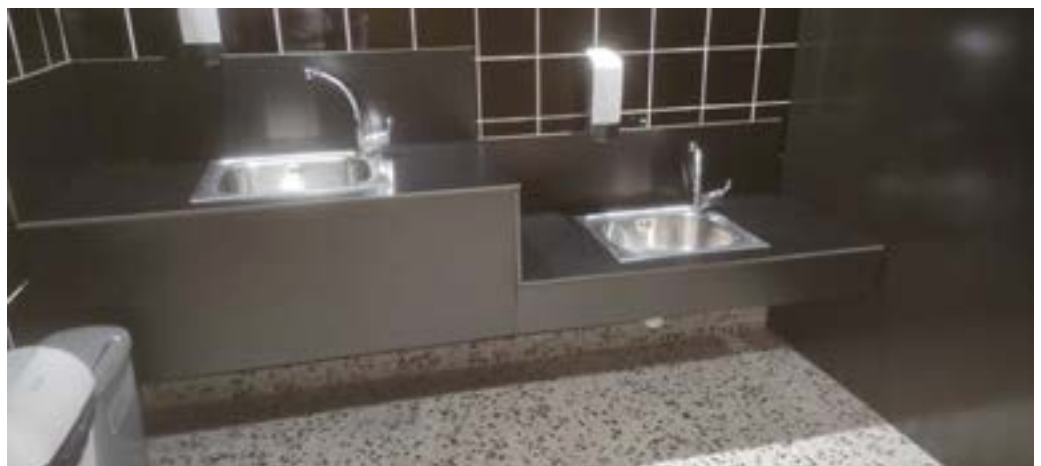
Erabiltzaileak eta beharrak anitzak dira: Erreenteriako Lekuonan tamaina desberdineko pertsonetara egokitu dira komunekeko elementuak eta dimentsioak.
