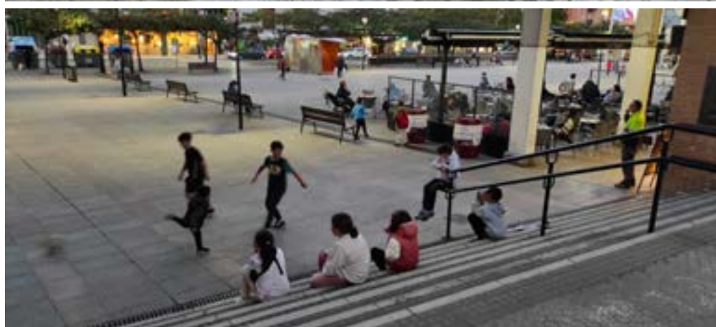
Mailagainetan zerrenda kontrastatua jartzea garrantzitsua da, desnibelak detektatzen laguntzen baitu.
