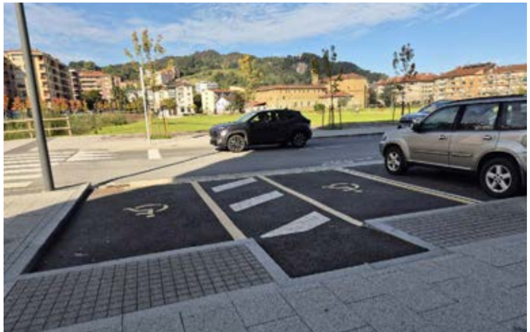
Goiko bi irudietan: Bi aparkaleku egokitu bationer: transferentzia-eremua partekatua da, eta ibia bertan eraiki da, asfaltozko arrapala baten bitartez. Zarautz.
