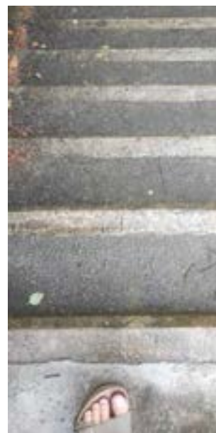
Kromatikoki desberdidutako mailek segurtasun baldintzak areagotzen dituzte.
