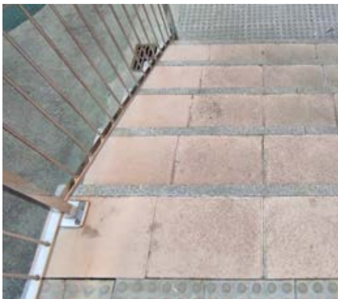
Kromatikoki desberdidutako mailek segurtasun baldintzak areagotzen dituzte.
