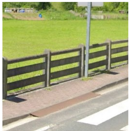
Goratutako zebra-bideek oinezkoen ibilbidea errazteaz gain, malda leunegia ez denean, ibilgailuen abiadura moteltzen laguntzen dute.
