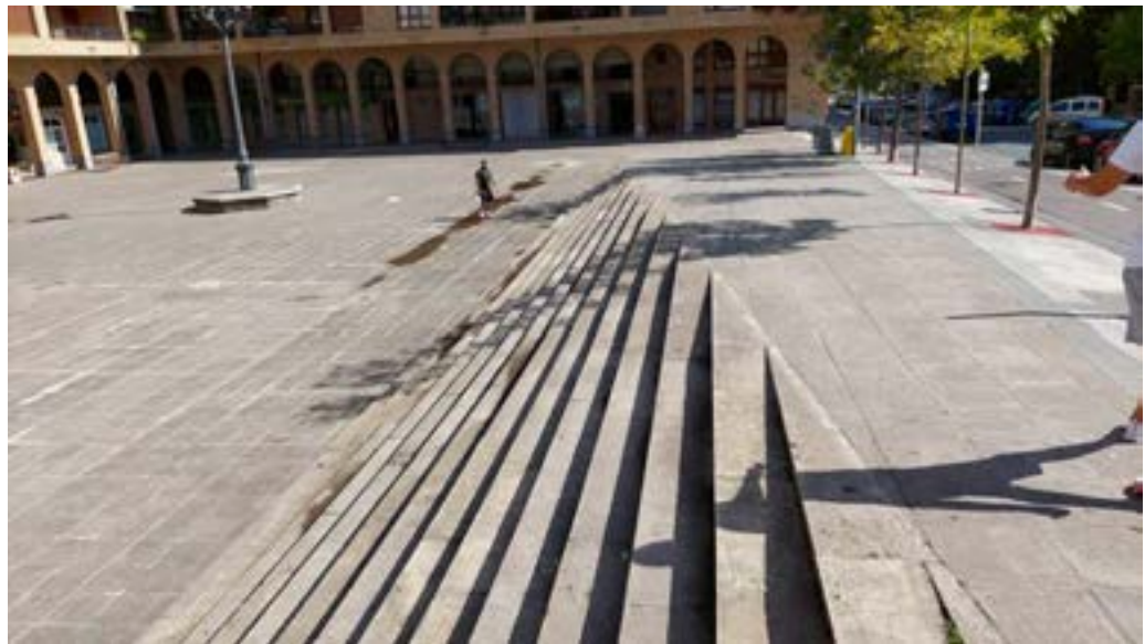
Oso ohikoa da eskailerak aldapen kontra errematatzeko modu hau. Irisgarritasunaren eta segurtasunaren ikuspegitik ez da irtenbide ona.
