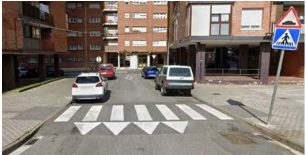
Goratutako zebra-bideek oinezkoen ibilbidea errazteaz gain, malda leunegia ez denean, ibilgailuen abiadura moteltzen laguntzen dute.
