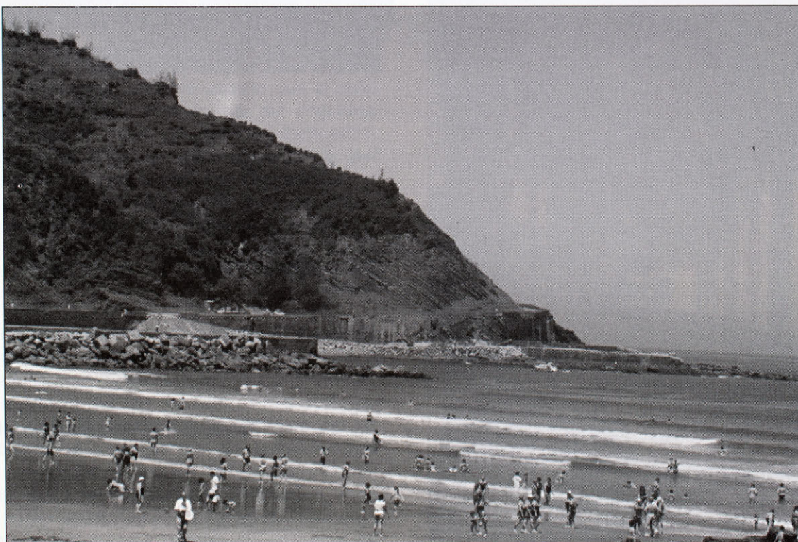
Vista del dique rompeolas, donde se aprecian los preparativos para iniciar las obras de reparación (Foto: P. Aldabaldetrecu)
