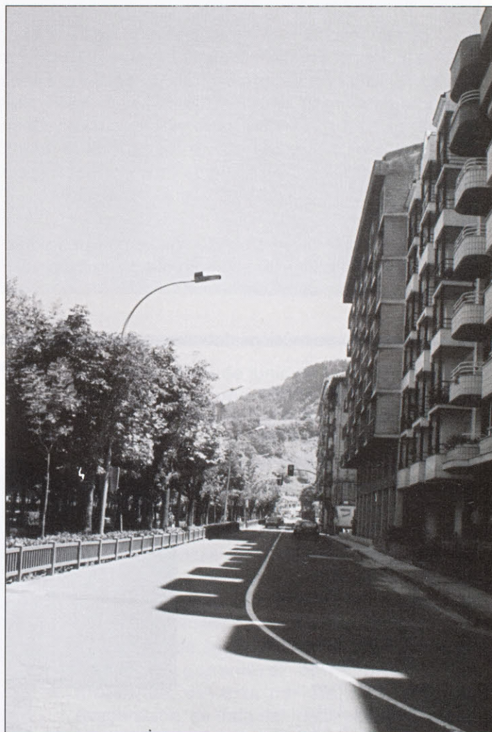
Valla de separación instalada recientemente (Foto: P. Aldabaldetrecu)
