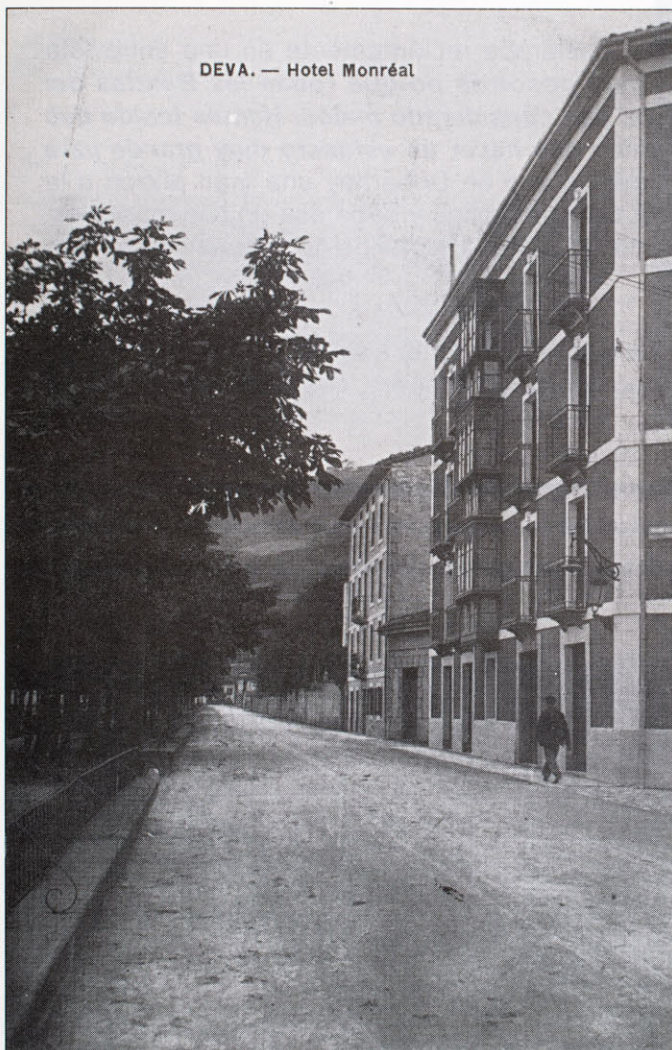
Antiguo banco corrido de separación entre la alameda y la carretera (Foto cedida por P. Aldabaldetrecu)
