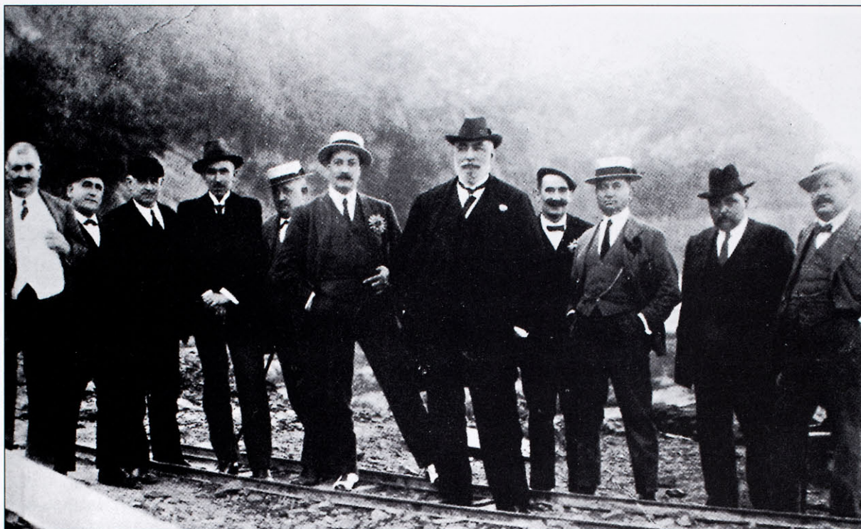
20 de Noviembre de 1913. Fermín Calbetón, visita las obras del dique de la margen izquierda de la ría. (Foto: "Deva Ayer")
