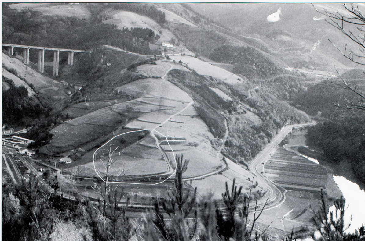
Proyecto de emplazamiento en Irarrazabal Burua (Arzabal). (Foto: Patxi Aldabaldetrecu)
