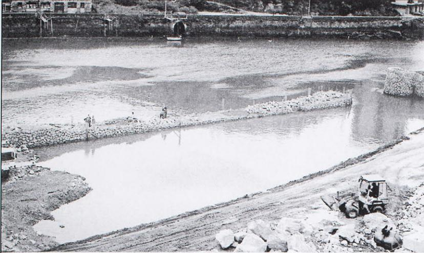
Los buzos ayudan a colocar unos cajones vacíos que se rellenan de cemento dentro del agua. Sobre aquel cemento se labran los muros de piedra y de ese modo surgen los muelles del puerto.
