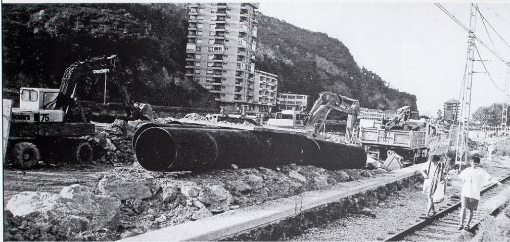
Se aprovecha la construcción de este paseo, para la instalación de los conductos de aguas fecales hacia Itziar.
