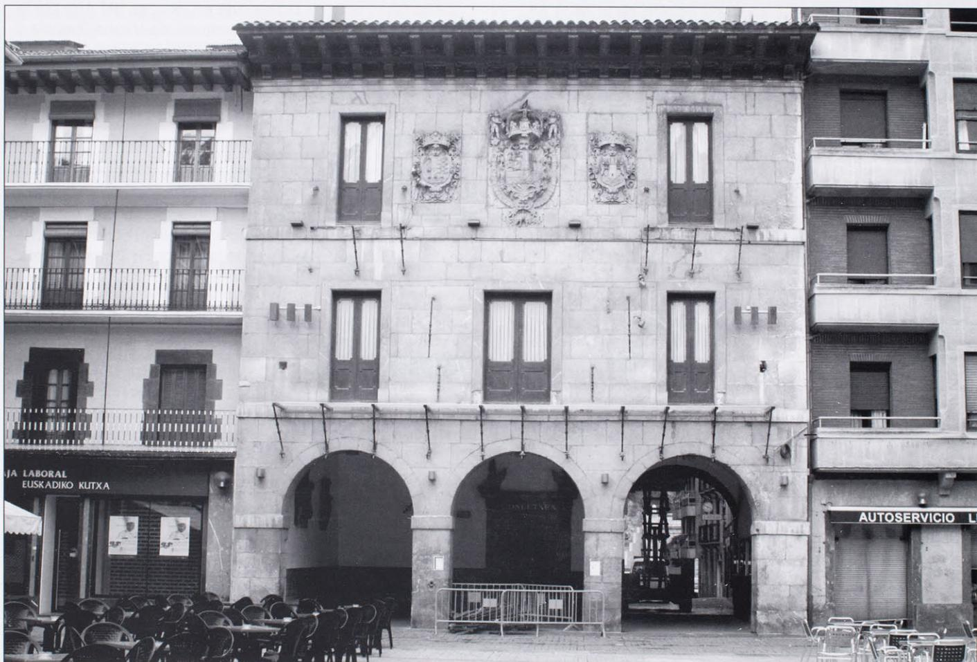
Vista reciente de la fachada principal desprovista de los balcones con balastrada de hierro fundido, retirados para su reparación y afianzamiento de sus soportes.
