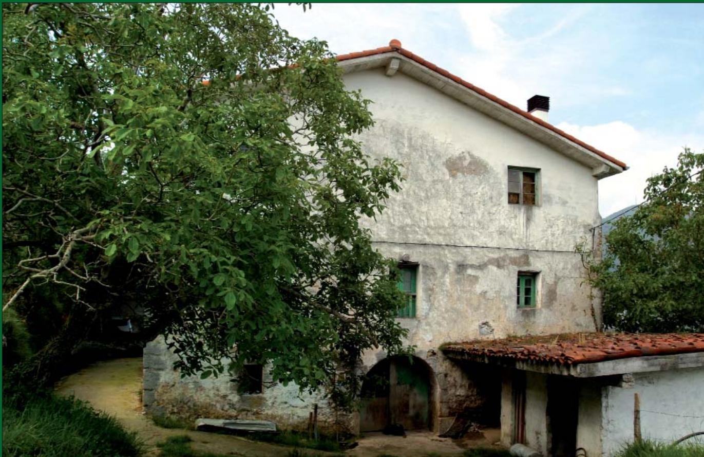
Vista de la fachada antigua de Goikoetxe, donde se puede destacar el hueco de la entrada de arco de medio punto dovelado y el recerco con piedra sillar de sus esquinales. (Roque Aldabaldetrecu. 06/2010)
