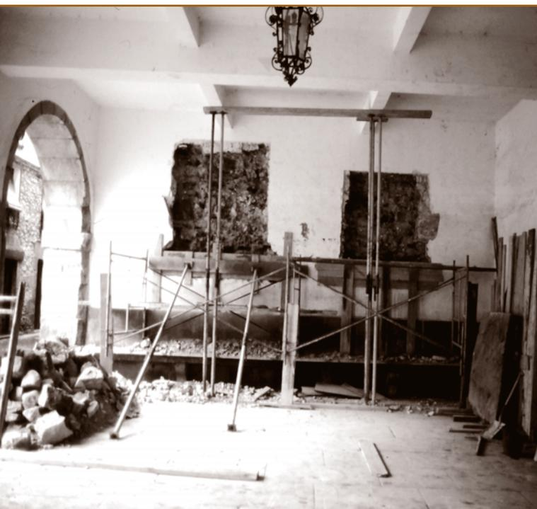
Obras de preparación de los huecos para encastrar el escudo de los Oliden y otro, en una pared de los soportales de la casa consistorial. Año 1986. (R. Aldabaldetrecu)
