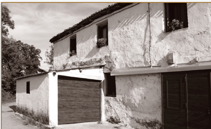
Sorasu txiki. Detalle de su fachada lateral derecha con el añadido. Octubre 2017.
