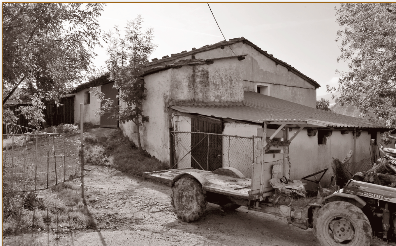
Sorasu txiki. Vista de la fachada trasera y lateral izquierda. Octubre 2017.
