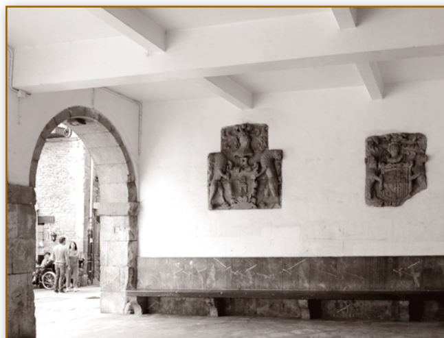
Vista del estado actual de las piedras armeras colocada en los soportales de la Casa Consistorial. Octubre 2017 (R. Aldabaldetrecu).
